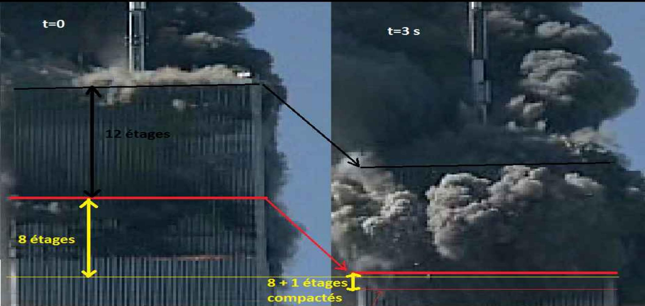
Un bloc rigide de 12 étages conduit à un front de destruction trop bas à t=3s
