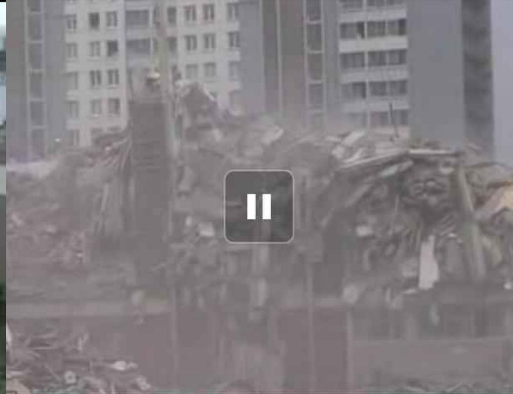
**Pas de “squibs” (projections de béton pulvérisé localisées sur la façade et en avance sur le front de destruction); Essentiellement des morceaux de béton: pulvérisation très faible constatée une fois le nuage de poussière retombé. La pile de débris est haute de presque 20% de la hauteur initiale contre moins de 3% au WTC. La pile de débris est typiquement de 12% la hauteur initiale du bâtiment dans les démolitions contrôlées!**
